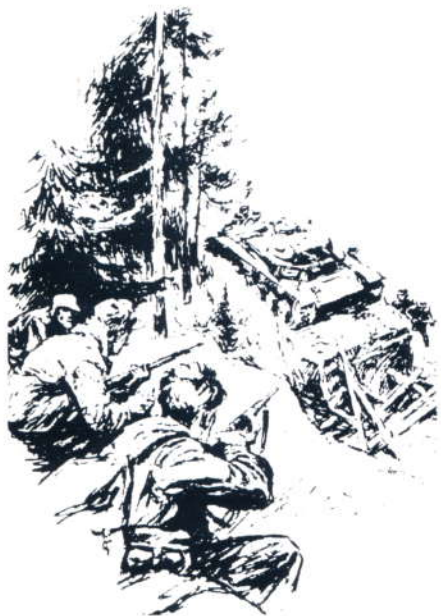
Tysk panser standses ved sprængt broovergang.
